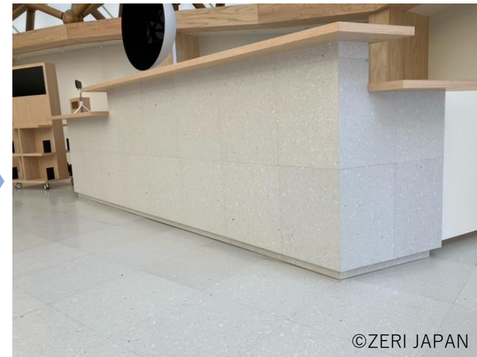
床材・化粧板として再利用（ドームC施工例）
